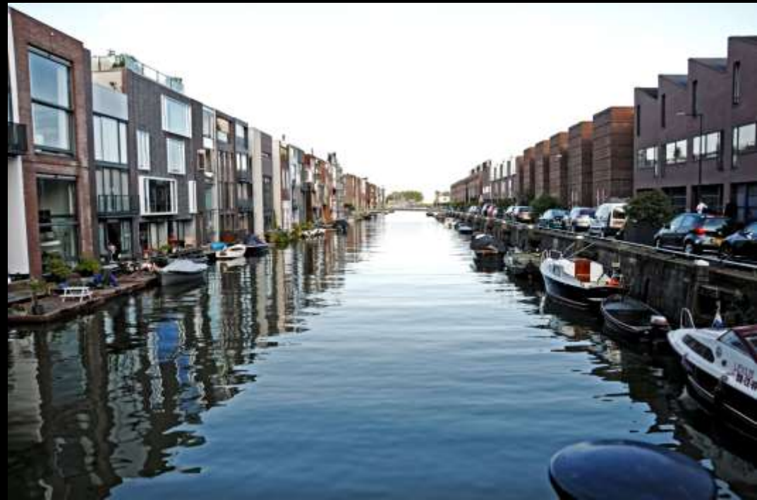
Moderner Siedlungsbau, Borneo-Inseln, 1995-2001
