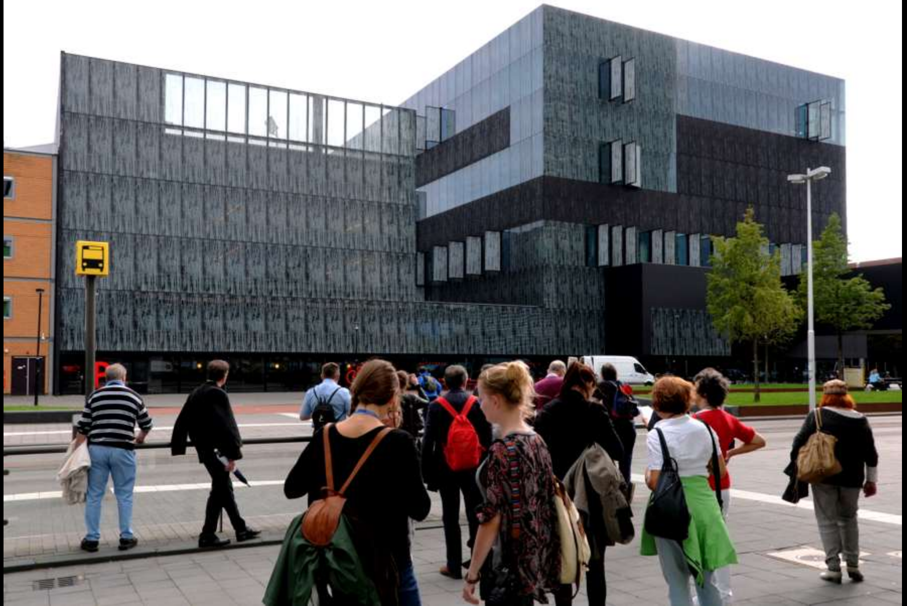
Weil Aret, Bibliothek, Campus Utrecht, Fassade
