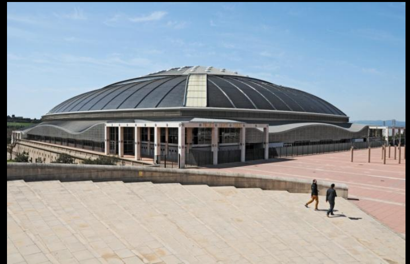
Arata Isozaki: Palau Sant Jordi, Neubau für Olympiade, 1990
