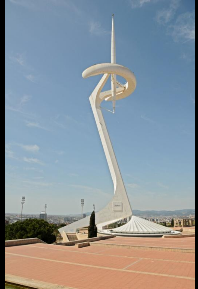
Santiago Calatrava: Torre de comunicacions de Montjuïc (Torre Telefónica), 1989-1992
